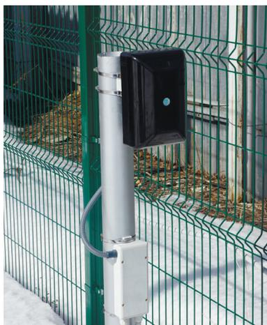
Принцип действия основан на работе двух каналов, работающих на различных физических принципах обнаружения: двухпозиционный радиоволновой и двухпозиционный инфракрасный.
