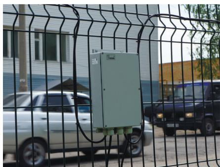
**Извещатель применяется** для защиты сетчатого или решетчатого ограждения от попыток перелеза через него или разрушения.
